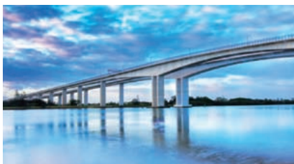
桥梁的劣化监测
